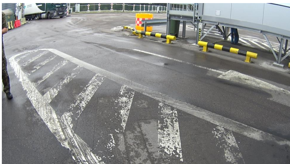
Fot. 6. Oznakowanie poziome – błędnie wykonane
